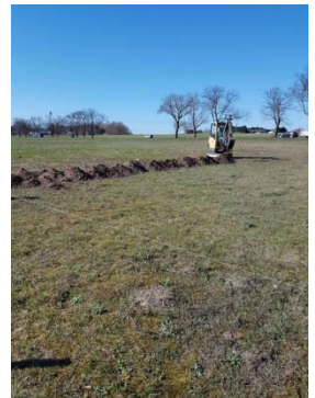
Das erste Foto unserer Baustelle
